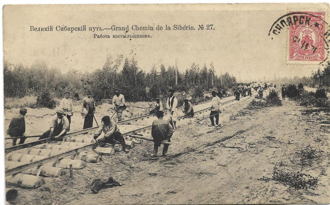
Transsibérien : pose et fixation des rails
