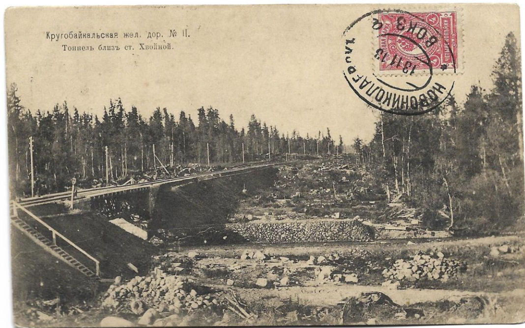
Transsibérien : pont et franchissement d'obstacle
