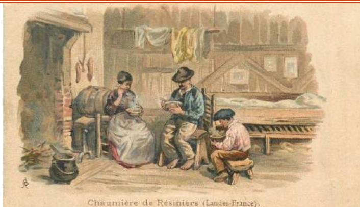
Chaudière de Résiniers (Landes-France).
