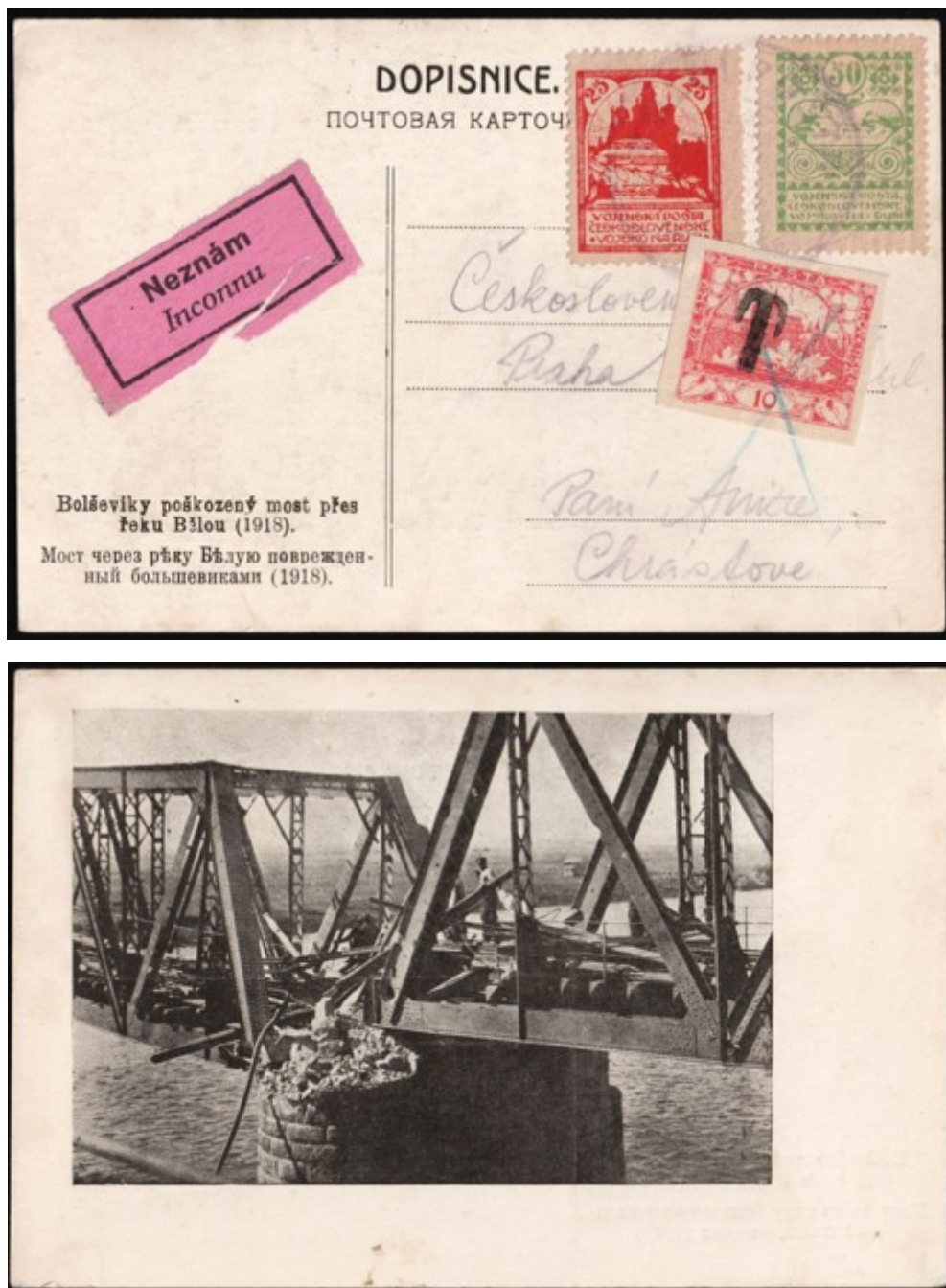
Figure 7 - Pont sur la rivière Bela
